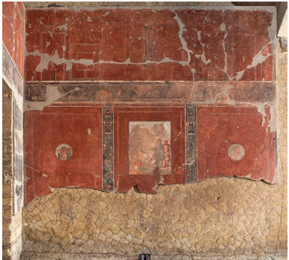
Fig. 4. Restauro delle pareti dipinte del tablino della Casa del Bicentenario (foto L. Rainer)
